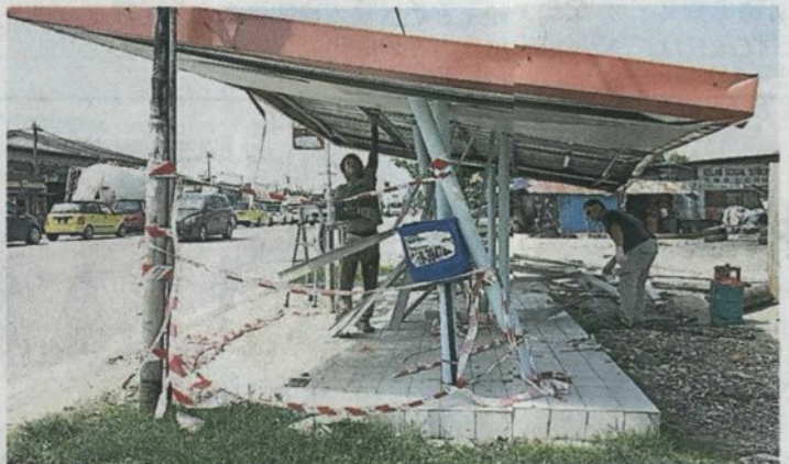
▲土毛月新村出入口旁的候车亭疑承受不住强风吹袭而“歪”了。
